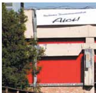
AFISARE BANNERE PE FATADA PAVILIONULUI C4
